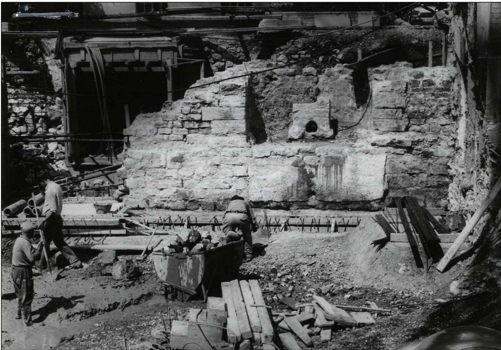
Freilegung der Apsis eines römischen Badebeckens 1967/68. Die Mauerreste geben einen Eindruck von der Grösse und Monumentalität der römischen Thermen.
